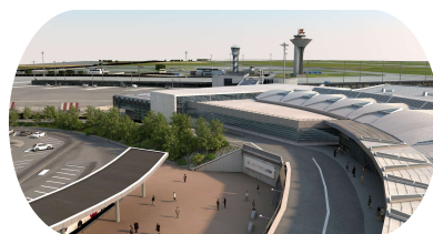
RÉNOVATION ÉNERGÉTIQUE DU T2
