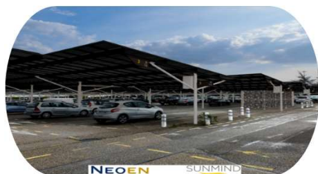
CENTRALE PHOTOVOLTAÏQUE EN OMBRIÈRES SUR 15 HECTARES
